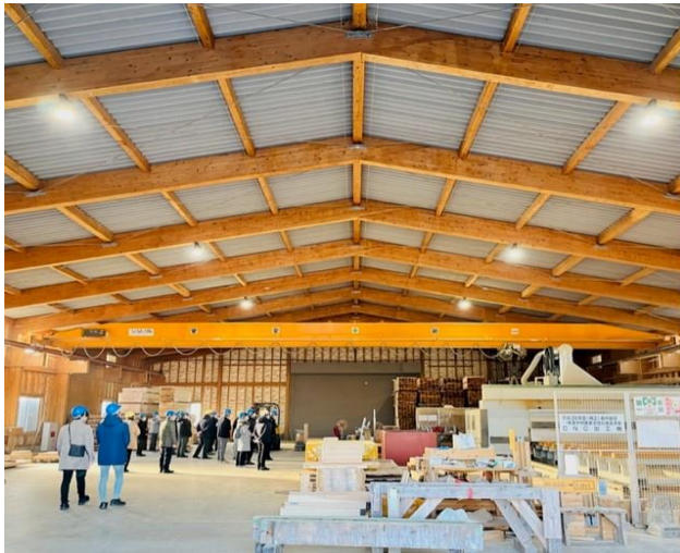
SAMURAI 集成材を用いたクレーン棟
