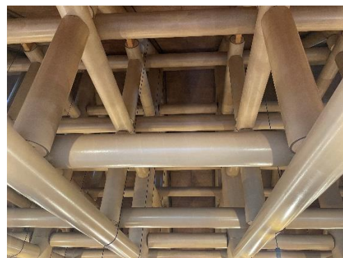
▲木軸の柱梁を再生紙による「紙管」で包んでいる
