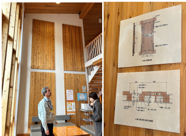
吹き抜けロビーや教室内にはCLT耐力壁を使用している
