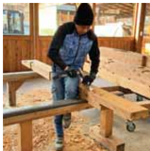
金物を使わない手刻みの伝統工法
