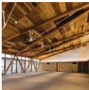
W型の柱と梁が支える無柱空間
